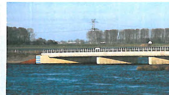
Moderne brug in de Noordwaard.
